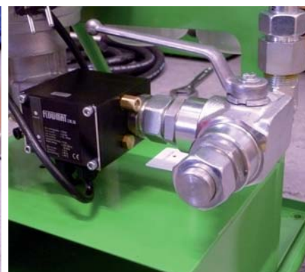
Vanne 3 voies pour vidange ou filtration
